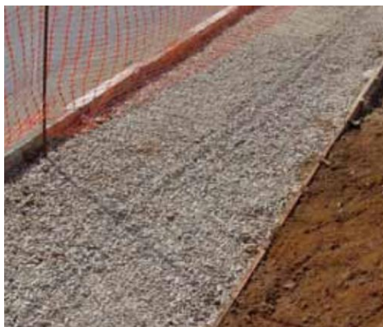
Figura 4 – Espalhamento da Camada de Brita
