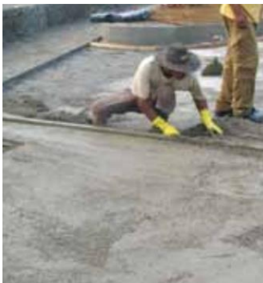
Figura 7 – Sarrafeamento do concreto
