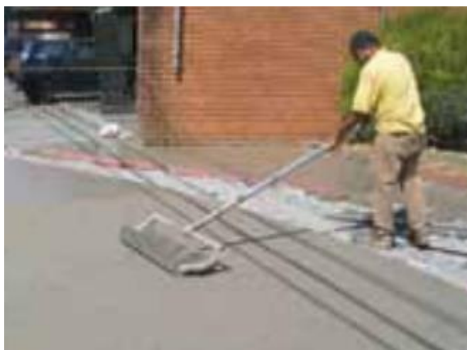
Figura 8 – rolo rebaixador de concreto
