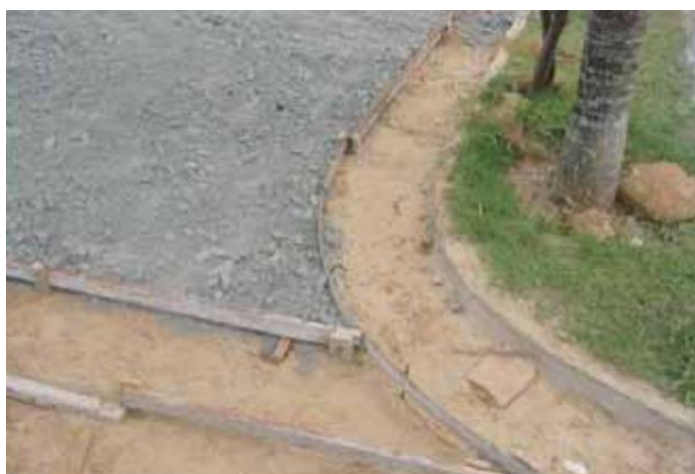
Figura 5 – Fixação das formas de madeiras
